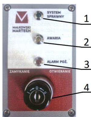
Rysunek 1. Przełącznik kluczykowy bramy kurtynowej ppoż.
